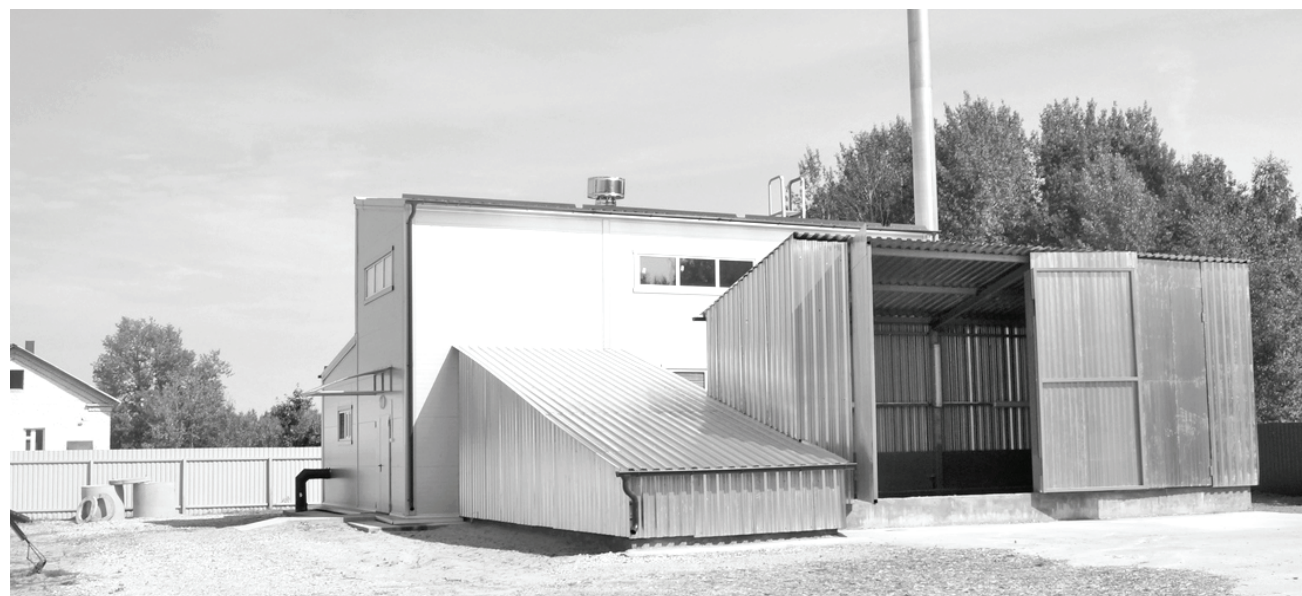
Котельная на биотопливе в п.Новый.
